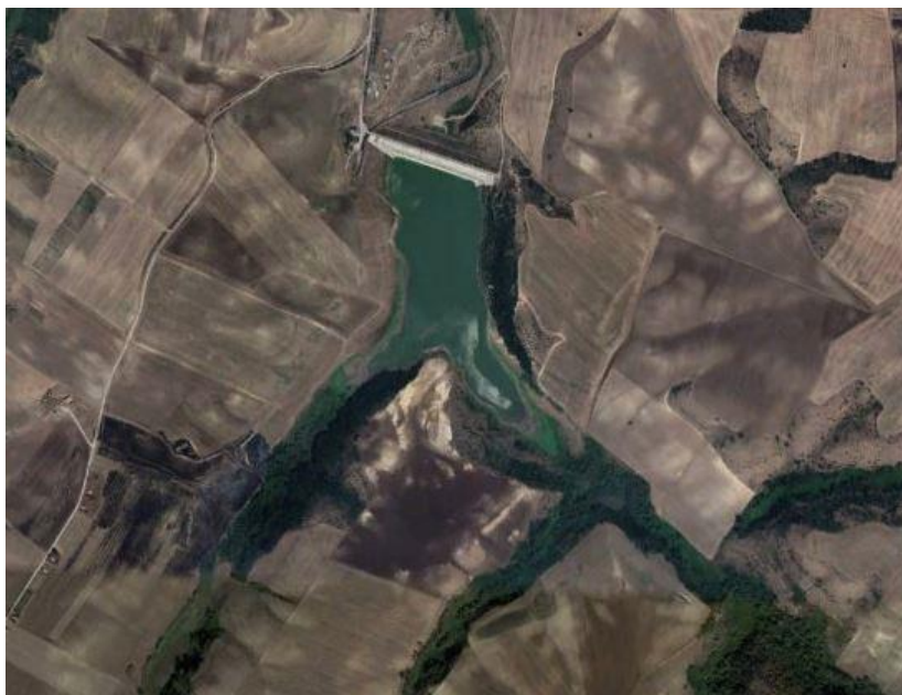
Fig. 2. Diga di Toppo di Francia
